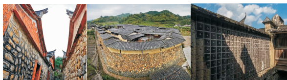
(a) 砖石结合 (b) 土石结合 (c) 瓦砾土挂瓦
